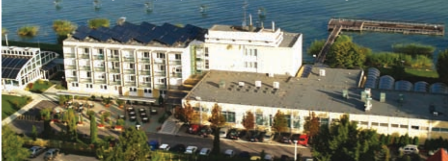
A balatonszemesi OTP-ingatlan tetejét napkollektorok fedik, használható hőenergiát állít elő.
